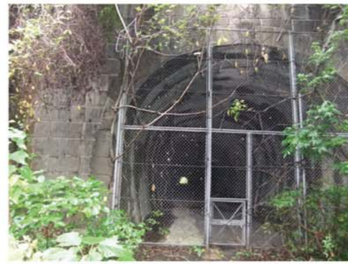
美保関町万原の旧森山隧道
